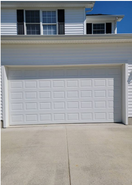
Exterior Garage Door Metal
